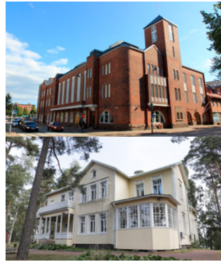
↑ ↑ Kotkan konserttitalon energiaratkaisut toteutetaan julkisivu- ja kulttuurihistorialliset arvot huomioon ottaen.
